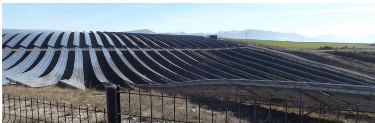
Figure 65 : Exemple de parc photovoltaïque au sol épousant les courbes de niveau (Alpes de Hautes-Provences)
