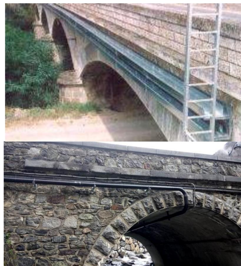
Figure 82 : Exemple de passage de câble par encorbellement (en haut : Installation de goulotte pour passage de câbles (Source : Nogues)) – en bas : Passage du réseau électrique dans des tubes acier (Source : 2cordesacordes)
