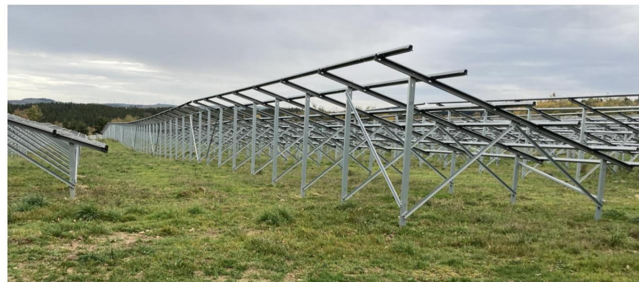
*Photo 9 : Montage des structures sur sol végétalisé (chantier d'un parc PV dans le Cantal, 2022)*
