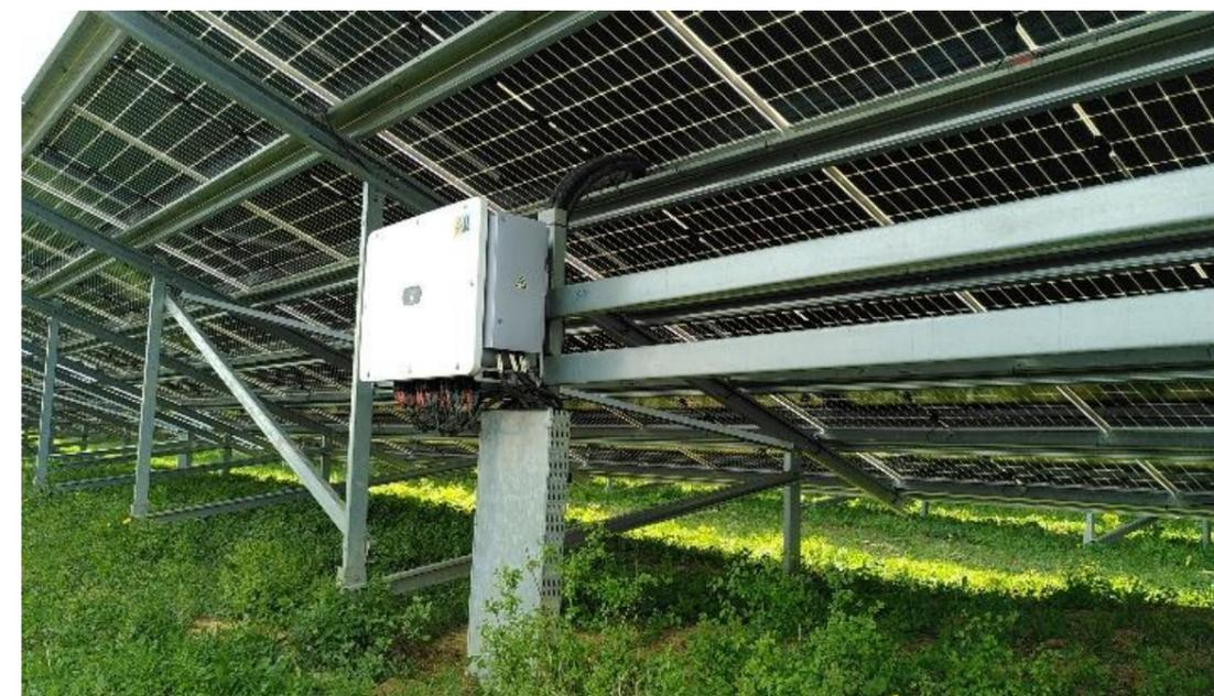
Figure 28: Exemple d'onduleur accroché derrière les tables de modules © TSE
