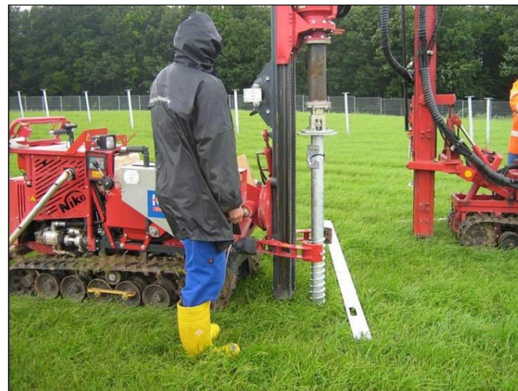
Figure 26 : Sonnette de battage hydraulique et machine hydraulique de vissage © TSE
