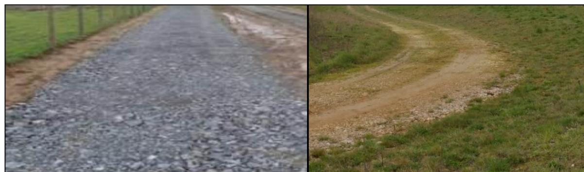
Figure 33 : Exemple de chemins d'exploitation (à gauche) et de piste légère (enherbée, à droite) © TSE
