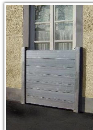
Exemple de batardeau en place
