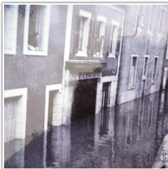
Crue à Chambon-sur-Voueize en octobre 1960
