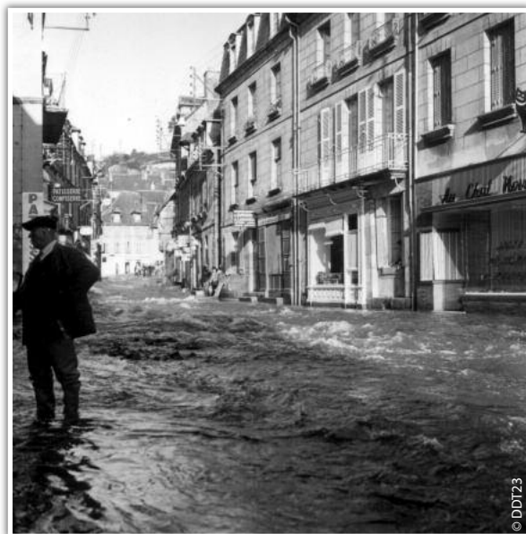
Crue à Aubusson en octobre 1960
